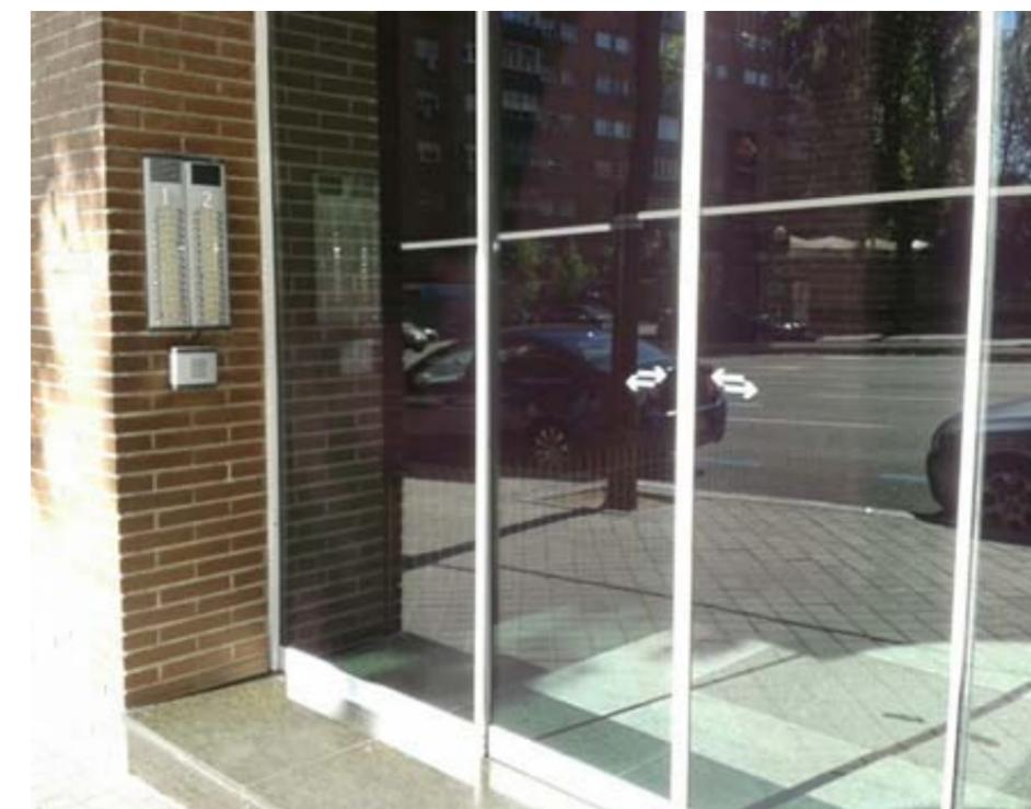
Puerta automática en el acceso a un portal (edificio de viviendas). El accionamiento de la apertura está controlado por un dispositivo de control de paso. Éste deberá estar a una altura accesible para su alcance y que permita la aproximación desde una silla de ruedas.
