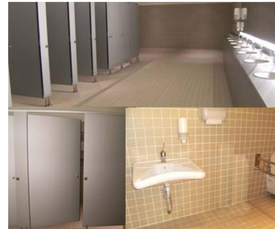
Ejemplo de cabina accesible con lavabo e inodoro en el interior de un aseo compuesto por una batería de cabinas.
