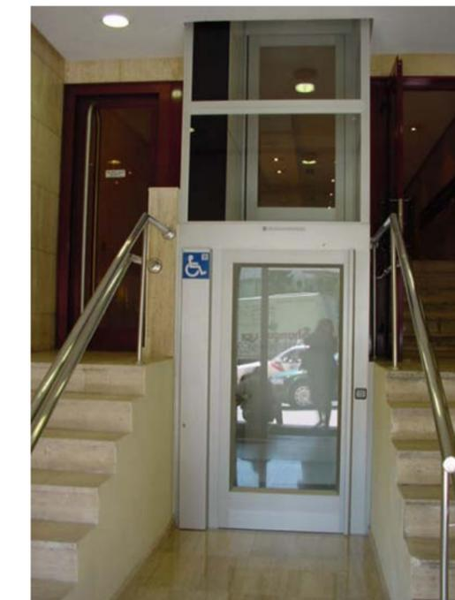
Siempre que sea posible se recomienda la instalación de plataformas de elevación vertical, que aunque a priori pueda ser una instalación más costosa, tienen garantizado su uso en las máximas condiciones de comodidad, seguridad y autonomía.
