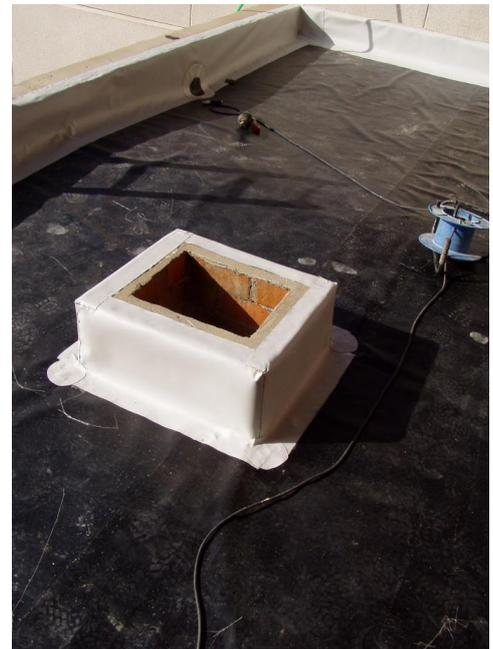
Fig. 4: Disposición de una lámina impermeabilizante de PVCp (la de color blanco, es resistente a la intemperie).
