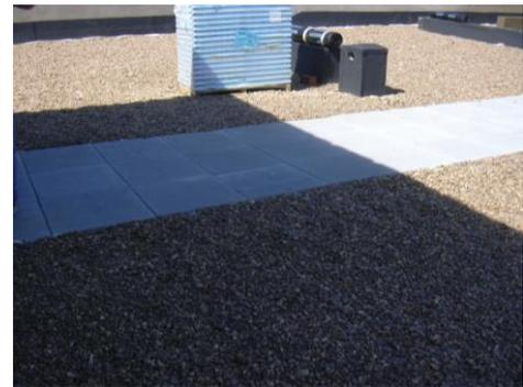
Fig. 3: Ejemplo de pasillo de mantenimiento
