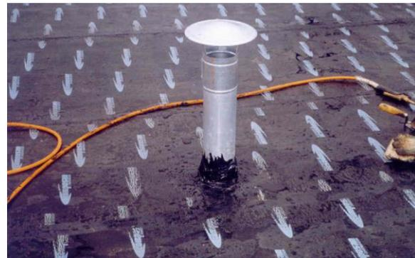
Fig. 2: Ejecución incorrecta de encuentro directo lámina-shunt
