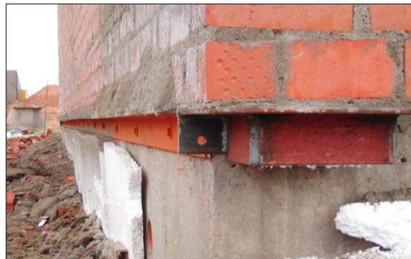
Fig. 2: Colocación de angulares para apoyo de fábrica en borde
