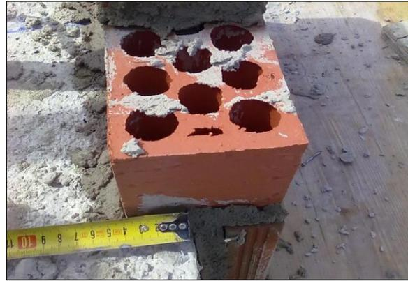
Fig. 1: Apoyo insuficiente de un ladrillo en borde de forjado
