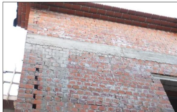
Fig. 2: Deficiente ejecución de fachada de 1 pie de espesor
