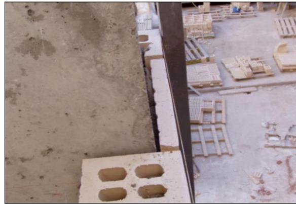
Fig. 1: Espesor insuficiente del emparchado de un pilar
