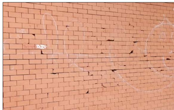
Fig. 2: Fábrica con junta oculta y existencia de desportillados
