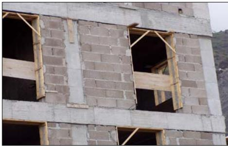
Fig. 3: Construcción de fachada de vivienda realizada con bloques (ejemplo de carencia de emparchados de la estructura, deficientes juntas verticales, etc...)
