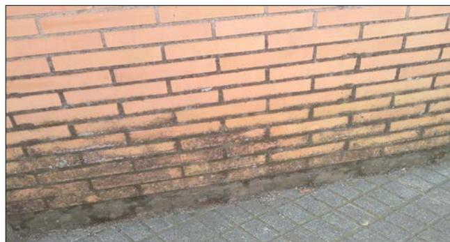
Fig. 11: Humedad en la parte inferior de una fachada cara vista debido a la falta de zócalo
