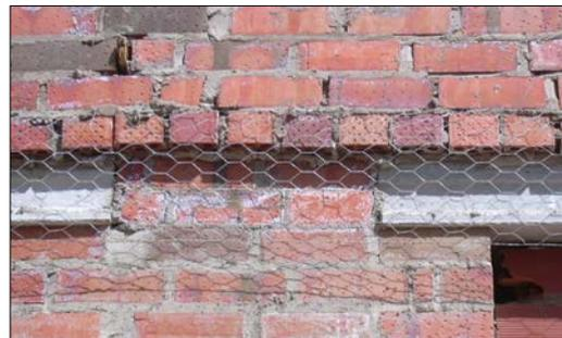
Fig. 6: Solución (mal ejecutada) en la que el dintel se realiza con vigueta doble T y se adiciona una malla metálica con solape en vertical insuficiente.
