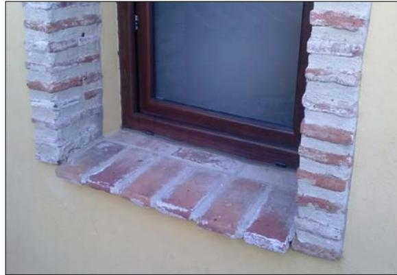
Fig. 1: Vierteaguas discontinuo realizado con ladrillo manual
