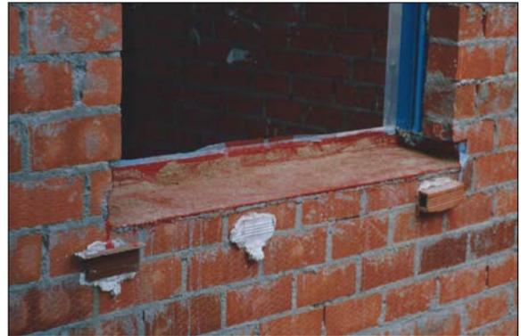
Fig. 4: Impermeabilización inferior de un vierteaguas
