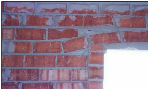
Fig. 5: Solución de dintel con arco de descarga
