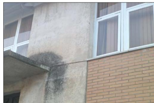
Fig. 8: Humedad debida a una solución inadecuada entre la fachada y el alero de hormigón
